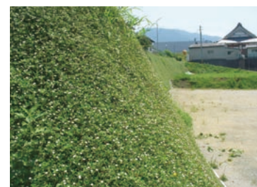
(写真-3) 法面緑化
